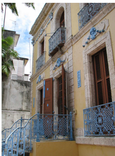
FIGURE 1 – Musée Schœlcher à Pointe-à-Pitre, Guadeloupe : bâtiment en calcaire s'élevant sur deux niveaux, ossature réalisée avec des pierres de taille appareillées qui structure des remplissages frustres.
