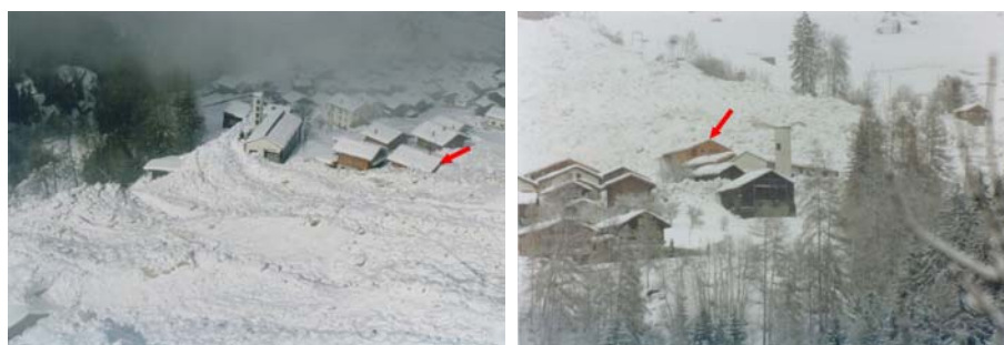
Figure 2. 5 Lourtier, Canton du Valais en Suisse, avalanche du 21 février 1999 (flèche rouge : construction récente intacte réalisée "conformément aux règles")
