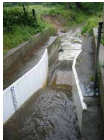
Figure 3 : station de la Léchère sur la rivière Chaudanne (a) et courbe de tarage estimée en échelle logarithmique (b). Les hauteurs sont en cm et les débits en L/s. En gris l'incertitude sur la courbe représentée par un intervalle de confiance à 95%. Les points sont les jaugeages représentés avec leurs incertitudes respectives.
