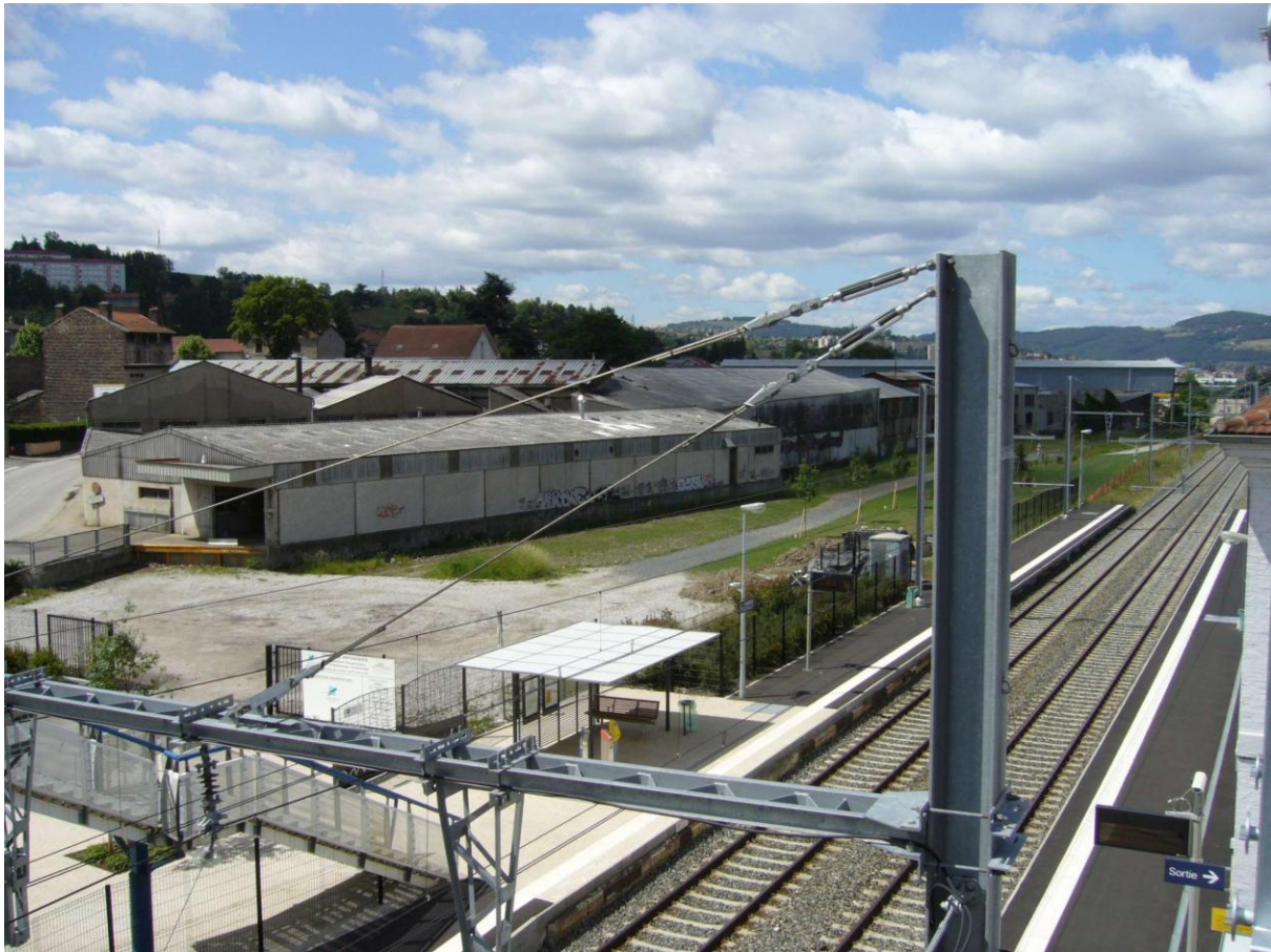
Figura 1: Vista del predial RFF (Red Ferroviaria de Francia) y de la fundidora situados al sur de la estación del Chambon-Feugerolles: datos de inicio de un proyecto urbano necesariamente flexible y evolutivo (fuente: Bahn.Ville 2).
