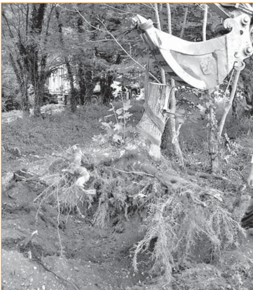
▲ Photo 1 – Excavation d'une souche vivante.
