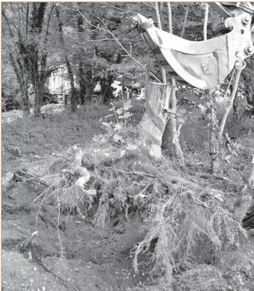
▲ Photo 1 – Excavation d'une souche vivante.
