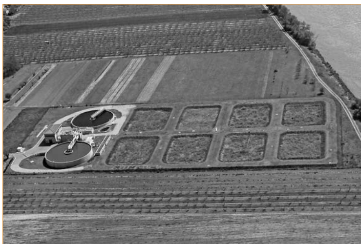
▲ Photo 1 – Vue aérienne de la station d'épuration d'Andancette (Drôme) avec les huit lits de séchage en taille réelle et les seize pilotes de 2 m 2 chacun pour les essais sur les matières de vidange et les boues seules et en mélange.
