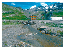
Dépôt de sédiments
