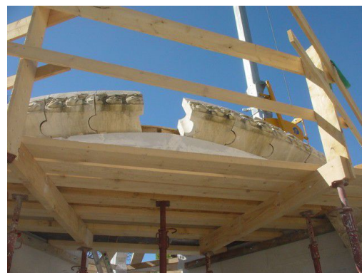
FIGURE 1 – Montage de la Coupole de Junas - Association des Pierres et des Hommes - 2011
