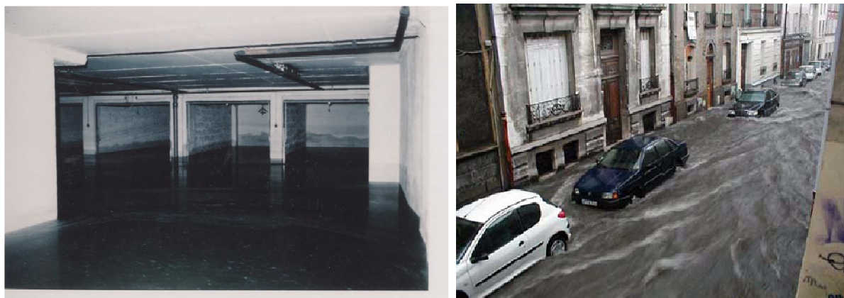
Figure 5 : Inondation d'un parking souterrain par remontée de nappe ; inondation en surface par remontée de nappe.
