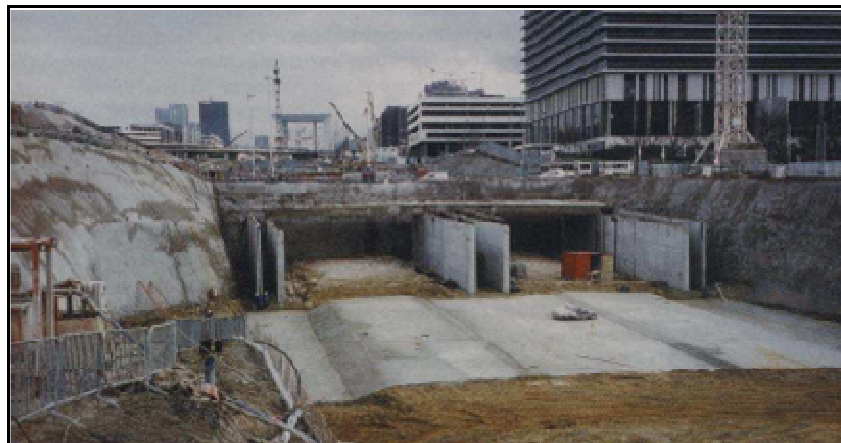
Figure 12 : Tranchée couverte en phase de construction, A86, la Défense.
