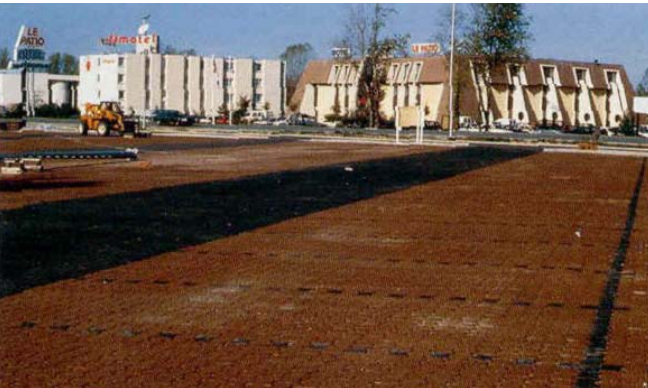
Cloison réalisée par un petit talus recouvert d'une géomembrane Craponne (69) - Photo Grand Lyon
