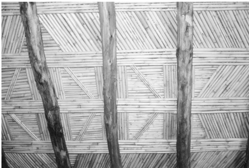
Figure 2. Toiture en roseaux vue de l'intérieur, village d'Hassy Lbyed (cl. M.-L. Gélard, 2005).
