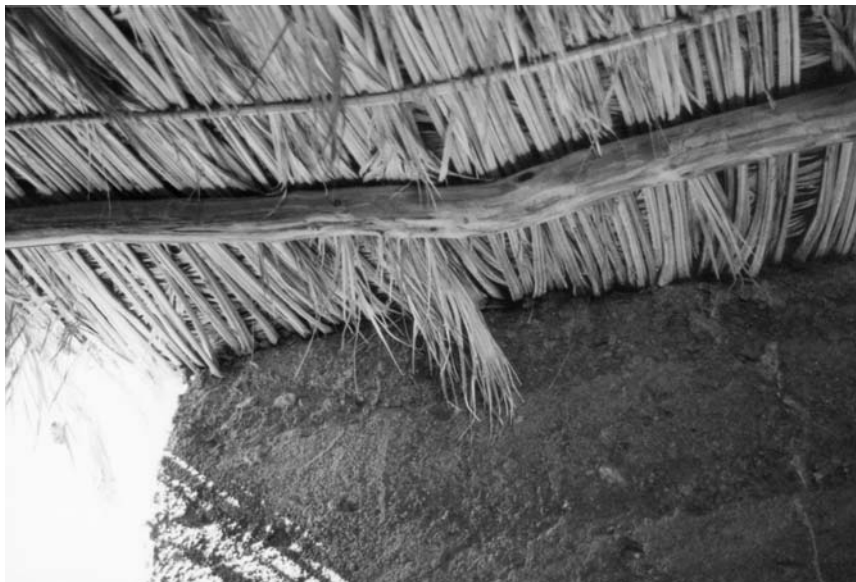
Figure 1. Toiture en palmes dans une demeure ruiniforme de Taqucht. Construction datant des années 1960 (cliché M.-L. Gélard 2005).
