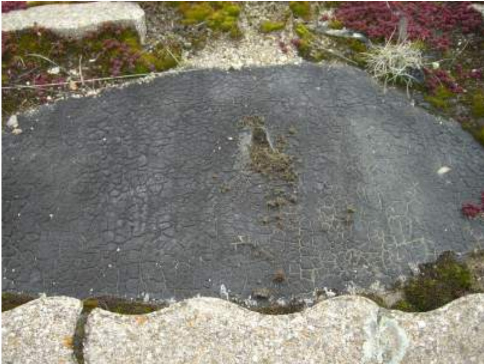
Figure 2. Aspect de la surface de la géomembrane du site 5 au moment du prélèvement
