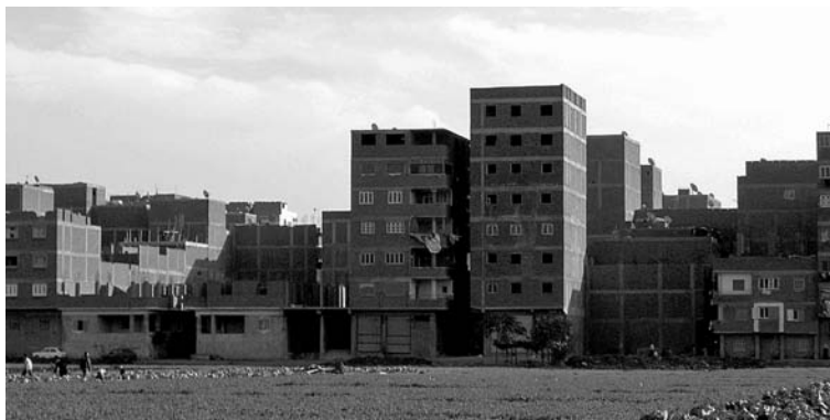
Quartier illégal sur des terres agricoles dans le gouvernorat de Giza, en périphérie ouest du Caire (M. Séjourné, février 2008).
