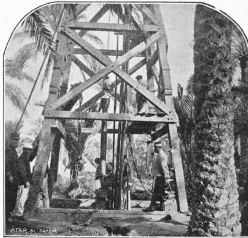
FIG. 29. — Forage d'un puits artésien près de Touggourt : l'atelier militaire de sondage dirigé par le lieutenant Jost.
