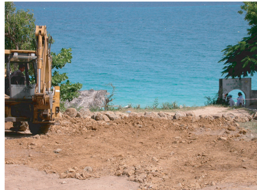
détail de la pose du matériau type 1
