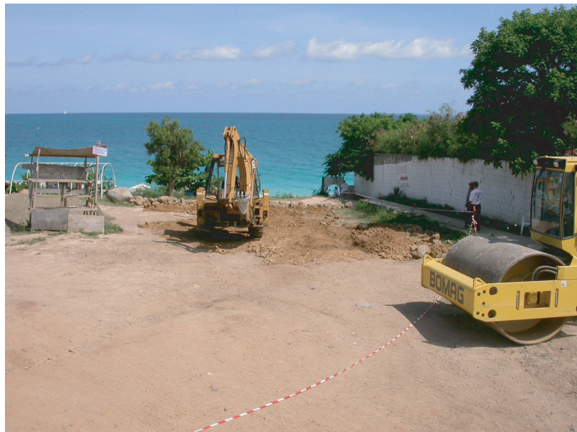
étalage du matériau type 1 dans l'angle nord-ouest
