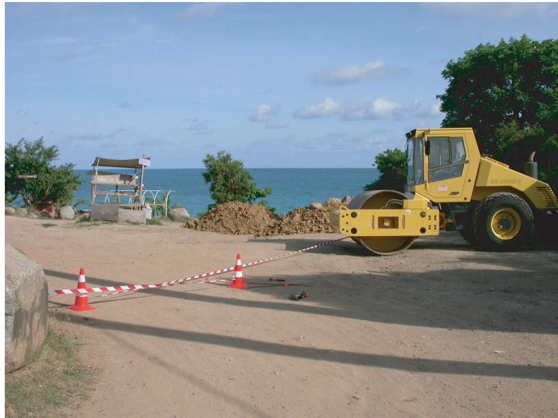
préparation du remblaiement
