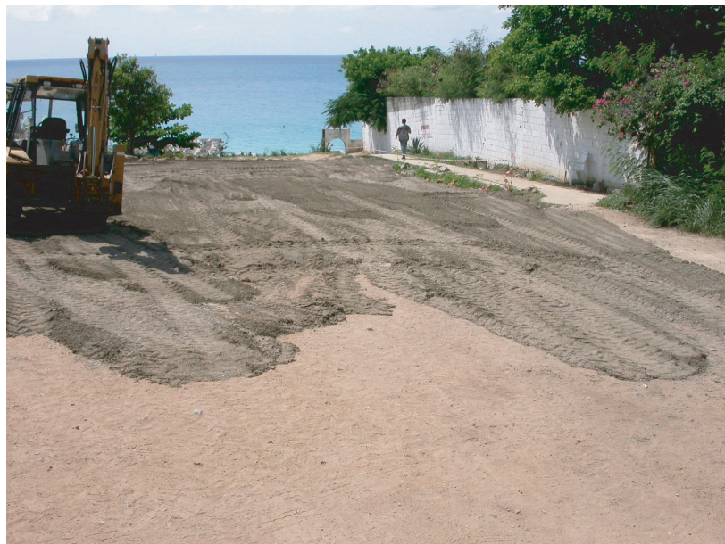
étalage du matériau de type 2
