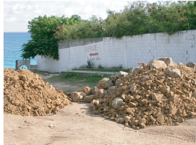
matériau type 1 déposé avant étalage
