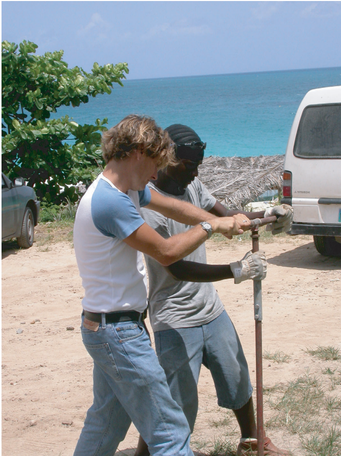
Réalisation d'un sondage à la tarière
