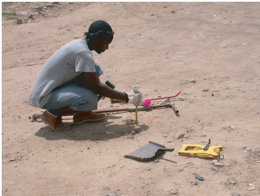
Préparation d'un sondage (perforation au burin de la couche superficielle caillouteuse compactée par le roulement des voitures)
