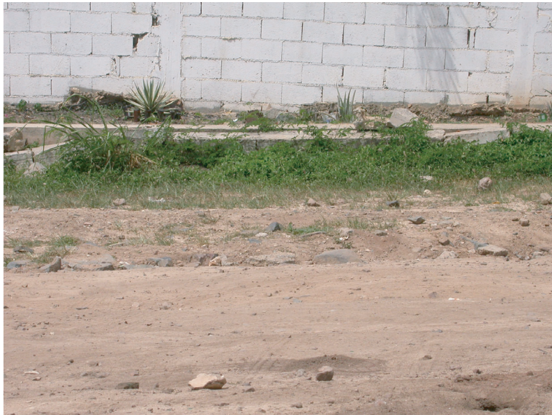
détail : zone nord, ravinements
