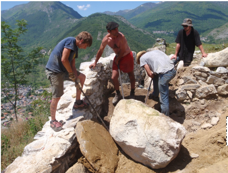
Dépose du bloc pour la destruction du M 49
