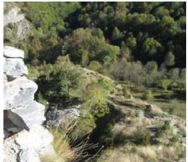
Figure 7 : site de l'ancienne tour vu de la tour du Campanal
