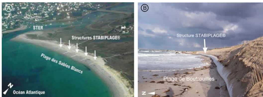
Figure 3. Vue aérienne des 5 STABIPLAGE® transverses mis en place sur la plage des Sables Blancs (A). Vue oblique du STABIPLAGE® implanté en pied de dune sur la plage Boutrouilles (B)
