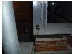
Figure 14 : Supportage de la machinerie sur patin acoustique
