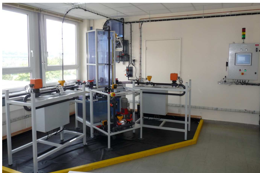
Figure 3 : Vue des stations
