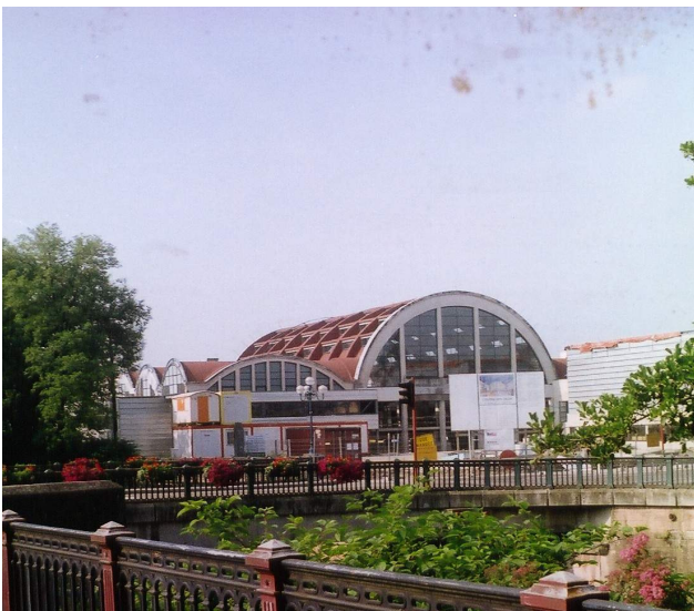
Figure 1 : Les anciens abattoirs de Belfort, emblématiques de la zone industrielle, reconvertis en complexe cinématographique
