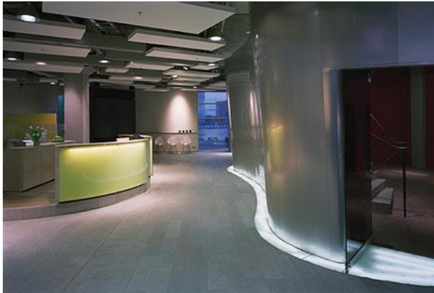
Figure 3 : Solutions acoustiques flottantes à base de laine de verre, 1998, IMP Publ., Malmö, Suède (Photo: Ecophon)
