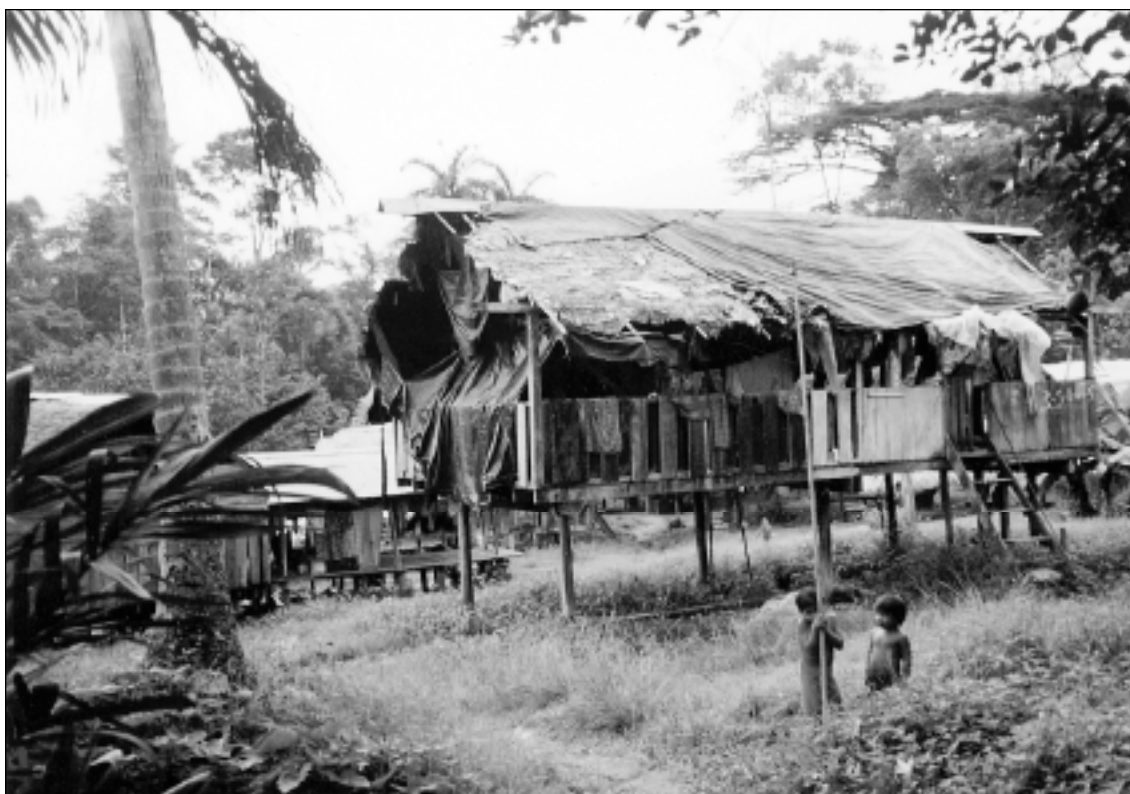
Maison Wayampi construite hâtivement suite à un plan de réaménagement, avec couverture en bâche. (cliché S.Bahuchet)
