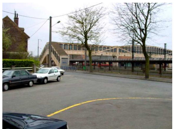
Photo 1 : la sortie Sud de la gare d'Arras, rue Emile Breton
