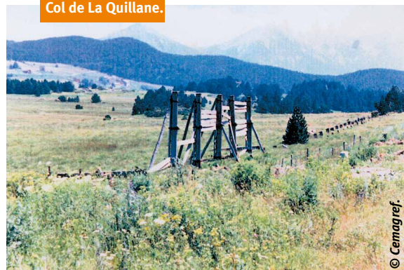
2 Barrières à neige protégeant l'aérodrome du Col de La Quillane.
