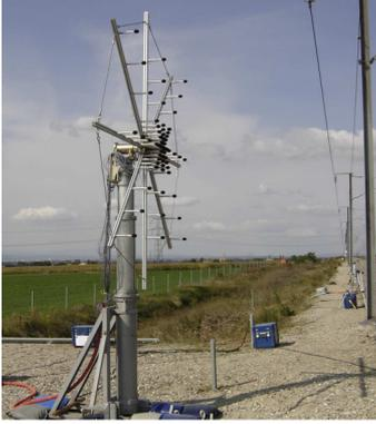
FIG. 1: Exemple d'antenne composée de deux étoiles encastrées.
