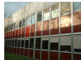
Figure 2 : Vue face Sud du bâtiment en contact avec l'extérieur
