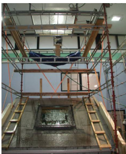
Figure 2 : Vue du banc d'essai VELUX
