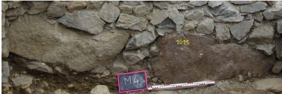
Base du M 4 – face sud-est Notez le bloc de granite à gauche et le bloc de gneiss à droite Ils sont posés sur la terre et constituent la fondation du mur.
