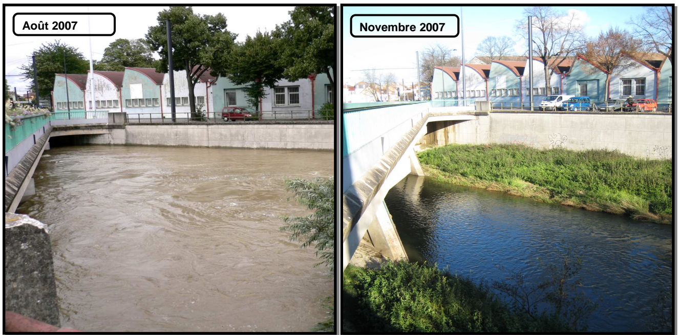
Figure 4 : Canal de décharge de l'Ill au croisement du boulevard Stoessel et du quai des Pêcheurs
