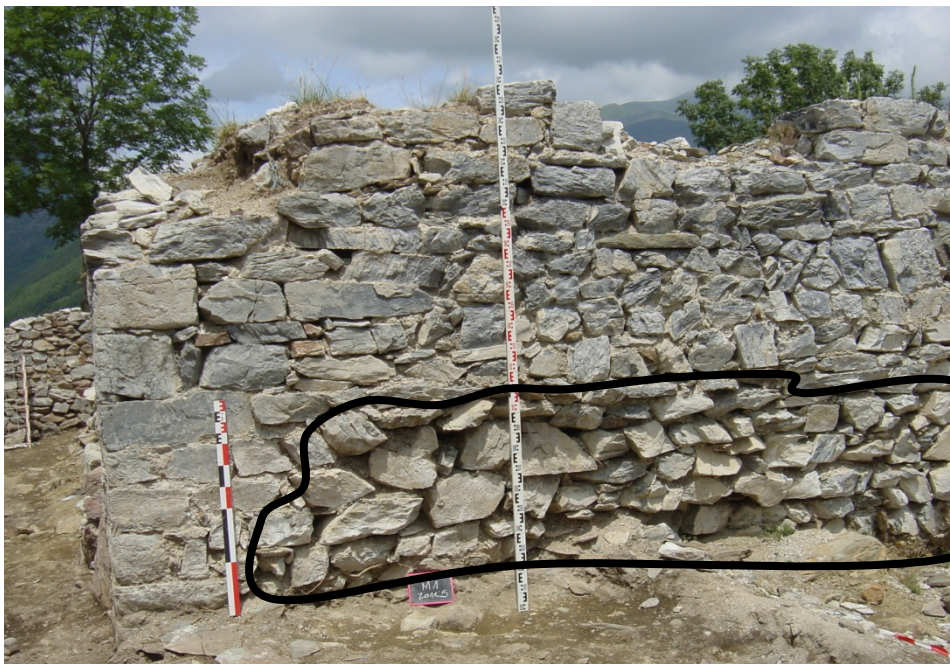
Fig. 11 : Tour maîtresse. Angle sud et face sud-est, zone 5. Mur en pierres sèches à la base de la maçonnerie de la tour maîtresse. La fouille a largement démontré sur toutes les faces du donjon que le tertre a été décaissé en étape 4 pour mettre à jour ces murs en pierres sèches.
