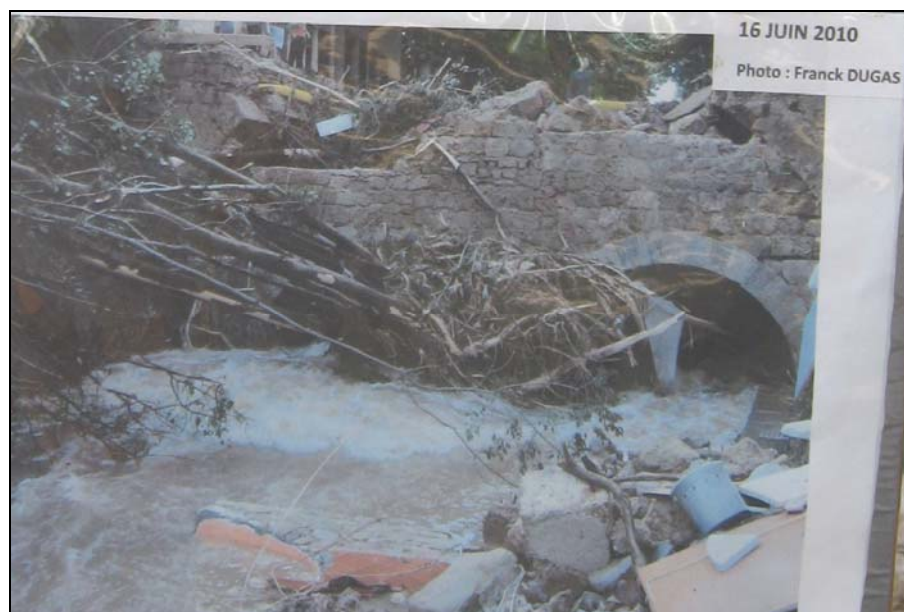
Photo 8 - Les Arcs-sur-Argens : l'entrée du Réal dans le tunnel à l'amont de la place Paul Simon, le 16 juin au matin.
