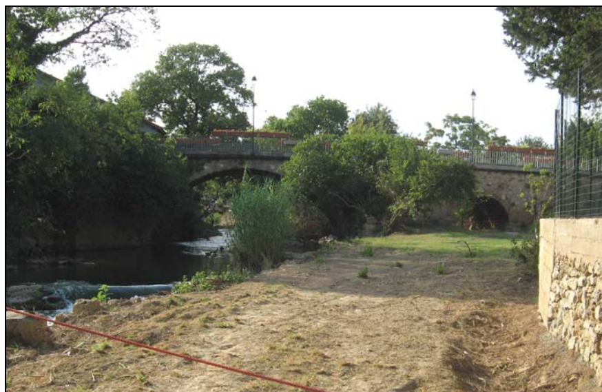
Photo 24 - Trans-en-Provence : le pont de l'avenue Marguerite de Provence, en amont du Pont-Vieux. Il associe une grande arche centrale à deux petites latérales ; celle de rive droite a été bouchée pour la construction d'une maison au bord de la rivière en aval immédiat du pont ; cette maison a bien sûr été inondée.
