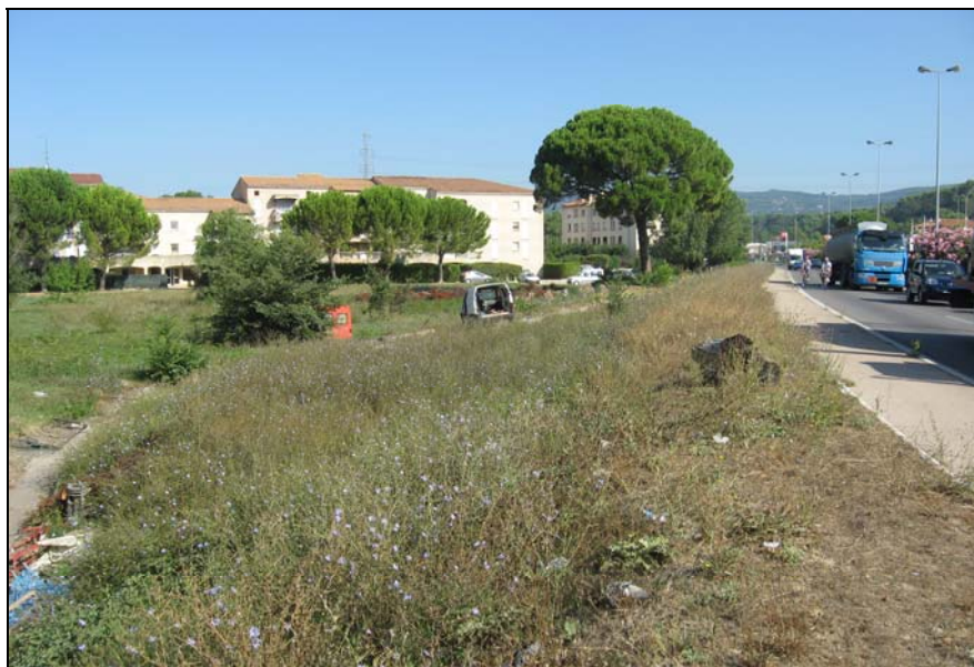
Photo 39 - Trans-en-Provence : les immeubles d'habitation en amont du remblai conduisant vers le pont de la RD1555. [cliché : C. MARTIN, août 2010]
