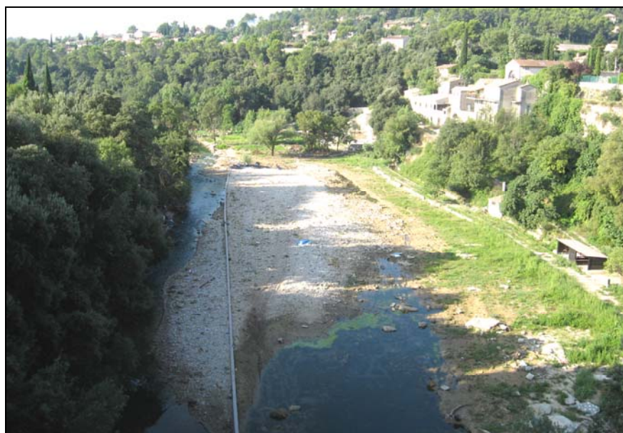
Photo 26 - La Nartuby en aval du village, vue du pont de la RD47, vers l'aval. La ripisylve a disparu en rive droite (près de la digue qui bordait jadis les bassins d'une ancienne pisciculture). En bas à droite, les débris déplacés d'une construction. [cliché : C. MARTIN, août 2010]
