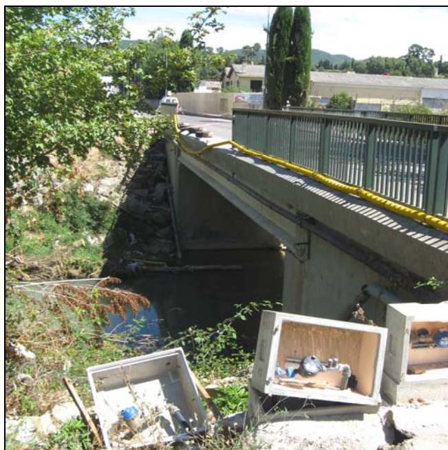
Photo 36 - Draguignan : un pont de la zone d'activité de Saint-Hermentaire. [cliché : C. MARTIN, août 2010]
