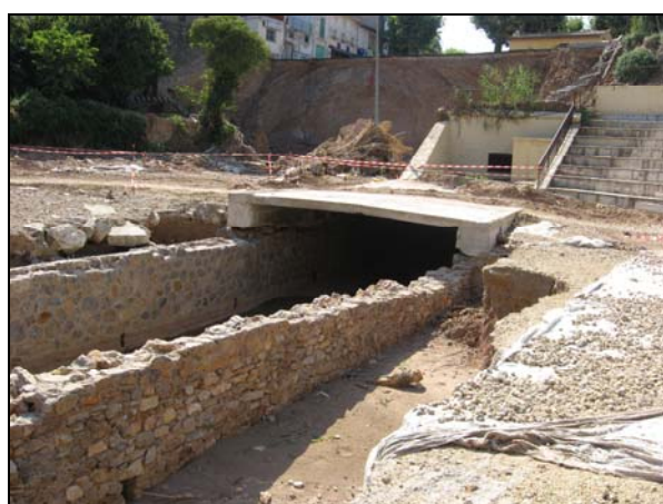
Photo 11 - Les Arcs-sur-Argens : le théâtre de verdure, le chenal assurant la sortie des eaux du tunnel et l'abrupt créé en dessous de la place. [cliché : C. MARTIN, juillet 2010]
