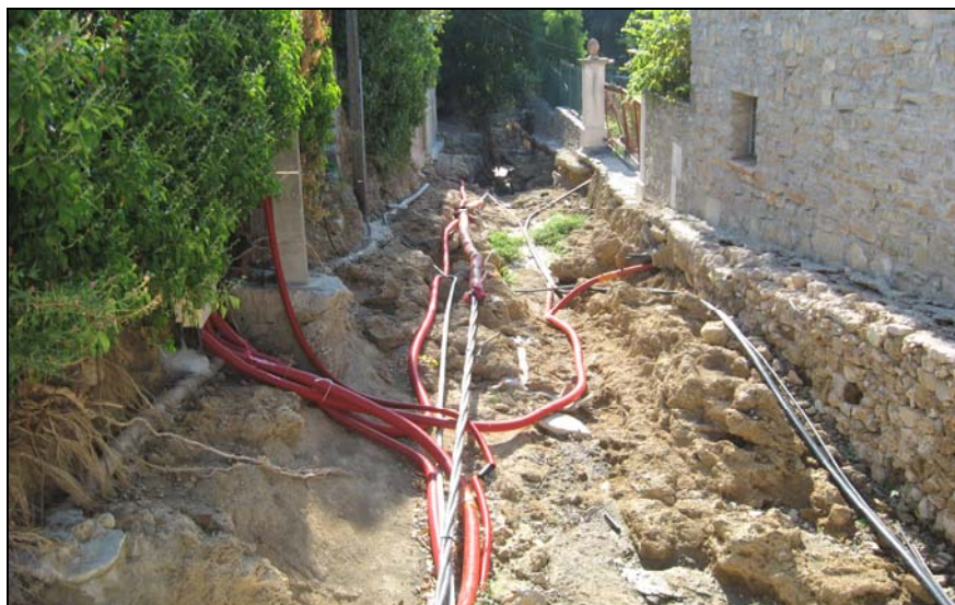
Photo 25 - Trans-en-Provence : ruelle empruntée par les eaux de l'avenue de Beaulieu pour rejoindre la Nartuby. [cliché : C. MARTIN, juillet 2010]
