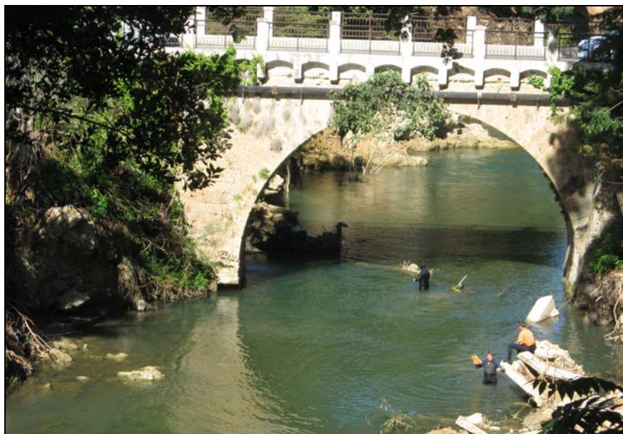
Photo 27 - La Motte : le pont de la RD254 (une équipe en train d'évaluer les dommages provoqués par la crue). [cliché : C. MARTIN, août 2010]
