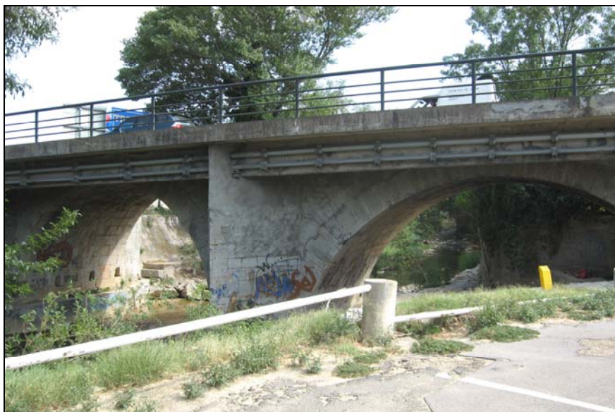
Photo 35 - Draguignan : le pont de la RD562 (pont de Lorgues). Des bâtiments commerciaux se trouvent au niveau de l'aire de stationnement à partir de laquelle est prise la photo...! [cliché : C. MARTIN, août 2010]
