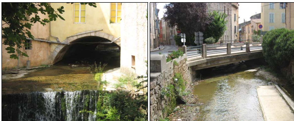
Photos 13 - Le ruisseau de Soliès dans sa traversée du Luc. Si les passages couverts sont assez largement calibrés (photo de gauche), les ponts et les passerelles (ici, à droite, le pont de la RD33) constituent des obstacles potentiels à l'écoulement des eaux par très forte crue.
