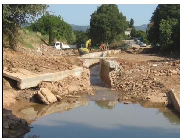
Photo 12 - Les Arcs-sur-Argens : le Réal immédiatement en aval du théâtre de verdure. Le chenal couvert offrait ici une section très réduite. [cliché : C. MARTIN, juillet 2010]
