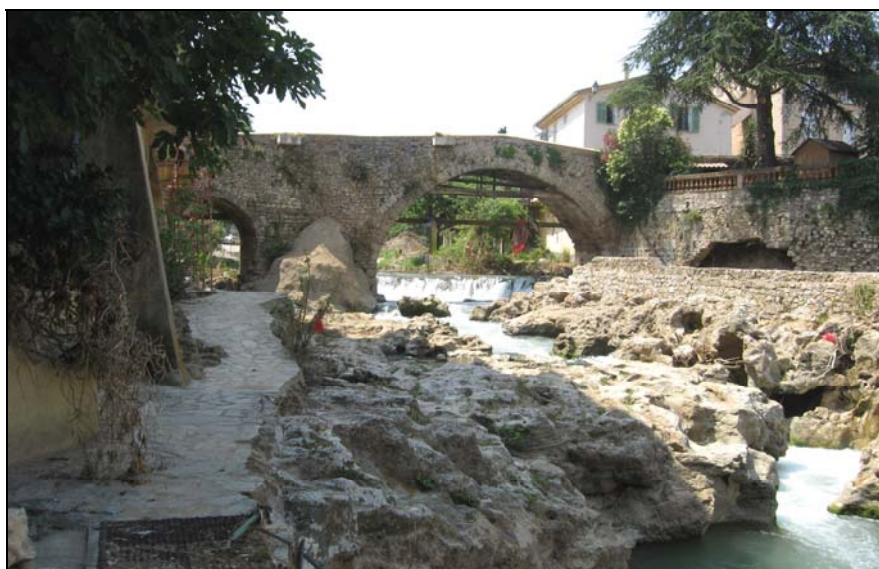
Photo 22 - Trans-en-Provence : le Pont-Vieux (XVII ème siècle) vu de l'aval. [cliché : C. MARTIN, juillet 2010]
