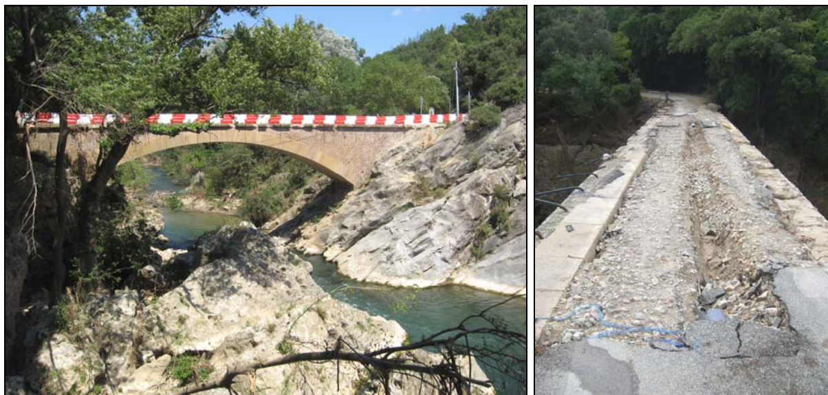
Photos 2 - Le pont de la Tournavelle, sur l'Argens, en aval du quartier des Badiés, sur la commune des Arcs-sur-Argens. L'eau est passée près de 2 m au-dessus du pont, défonçant la chaussée et arrachant les rambardes. [clichés : à gauche, C. MARTIN, août 2010 ; à droite, Cécile MARTIN, juin 2010]
