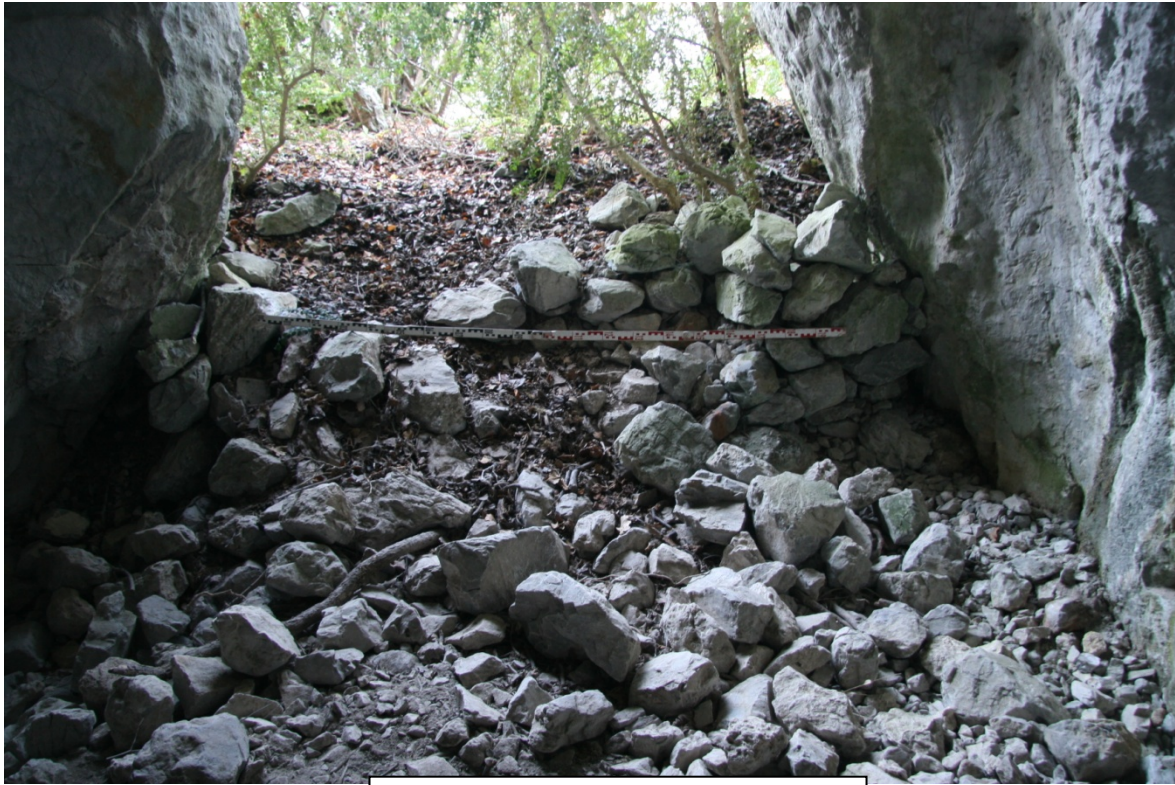
Mur barrant l'entrée de la grotte. Photo R. Ascargorta.
