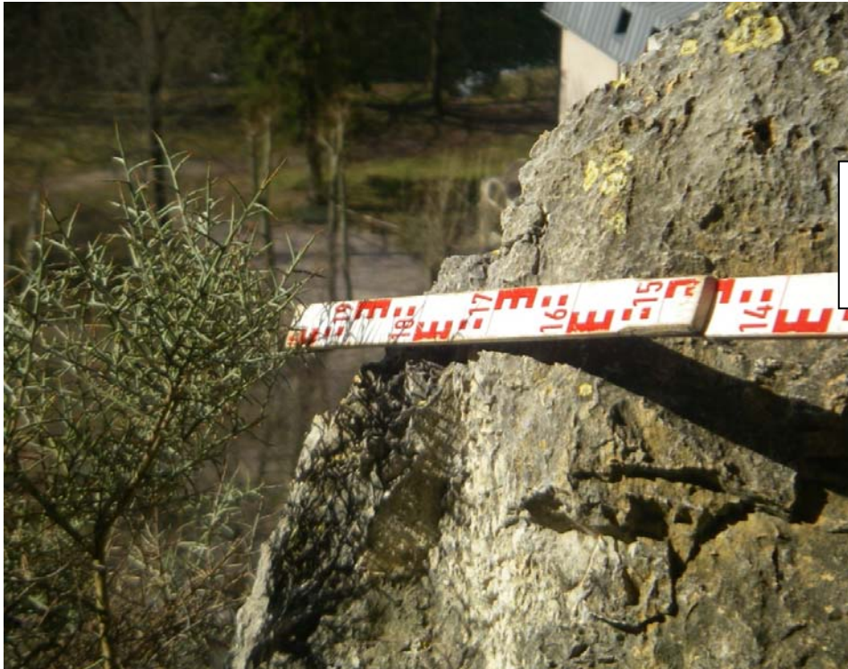
Grand porche – paroi nord Rainure verticale au-dessus du mur. Photo F. Guillot.
