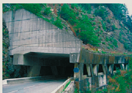
Galerie pare-blocs classique (Val d'Arly, Savoie)
