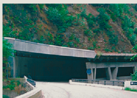
Galerie pare-blocs structurellement dissipantes (Val d'Arly, Savoie)
