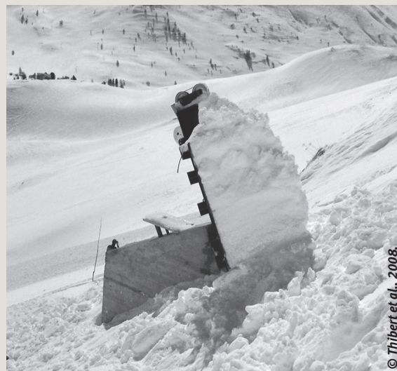
10b Dépôt de neige sur la structure
