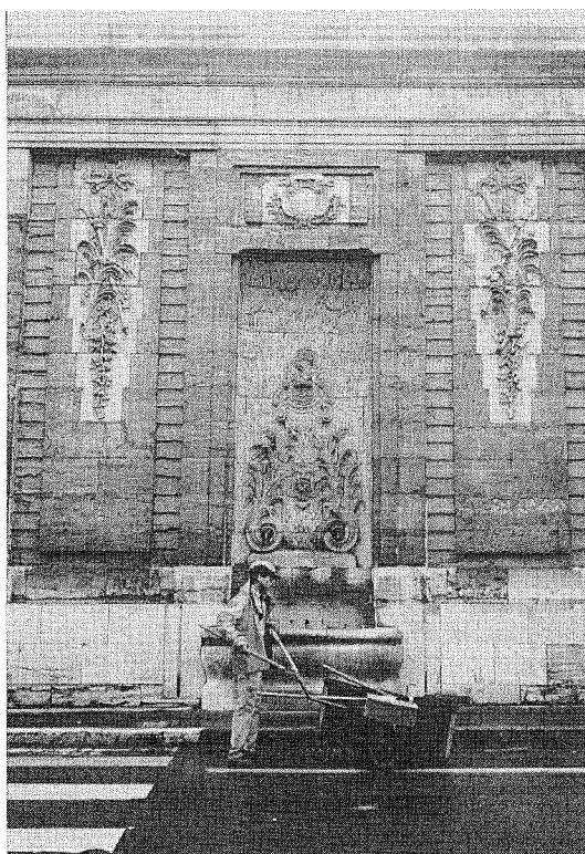
Fontaine de la Mairie, rue Mégevand, Besançon (1755)
