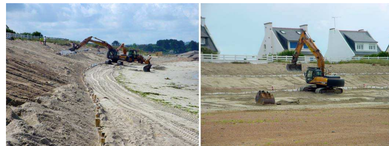
Photo 2 – Travaux de rechargement en sable et de reprofilage de la dune de la Grève Rose, s'accompagnant de la pose de brise-vent en géotextile (clichés Suanez et Fichaut, 26/06/2009).
