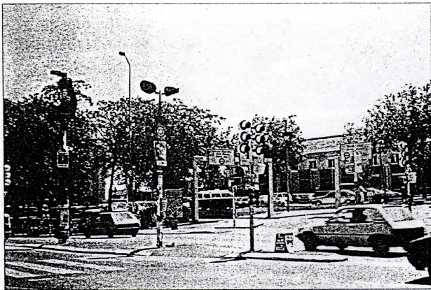
Des espaces extérieurs mal maîtrisés : La façade principale de la gare d'Avignon.
