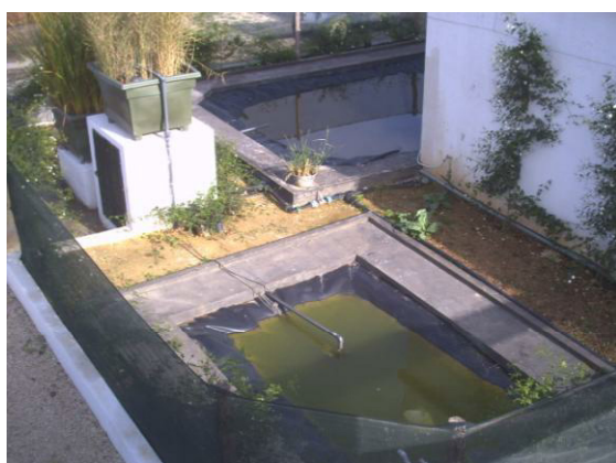
Ph.3+4 : Filière de traitement des eaux grises réutilisées dans l'arrosage des cultures ornementales
