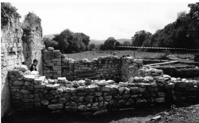
Fig. 5 - Portion occidentale de l'église préromane, mur septentrional au premier plan, vue depuis le nord-est (Cliché A. Bergeret).
