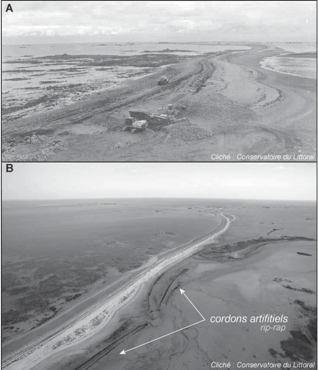
Photo 2 : Vues aériennes du Sillon de Talbert durant les travaux de suppression de la digue frontale en enrochement (A) et après la mise en place des cordons artificiels en arrière de la flèche (B)
