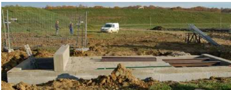
Figure 2. Fosse en béton armé (7 m × 4 m × 2 m)
