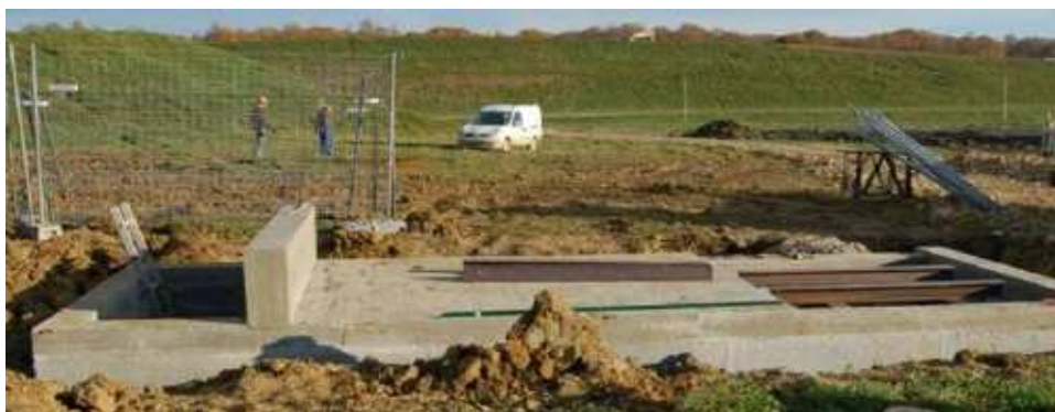
Figure 2. Fosse en béton armé (7 m × 4 m × 2 m)
