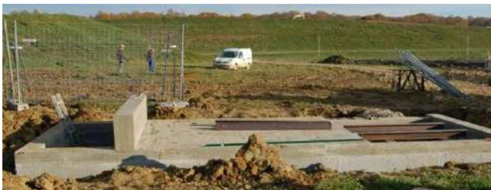
**Figure 2.** Fosse en béton armé (7 m × 4 m × 2 m)
