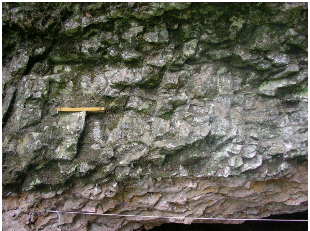
Figure 281 : détail de la paroi rocheuse montrant sa tendance à la fragmentation en petits polyèdres, cliché D. Sordoillet
