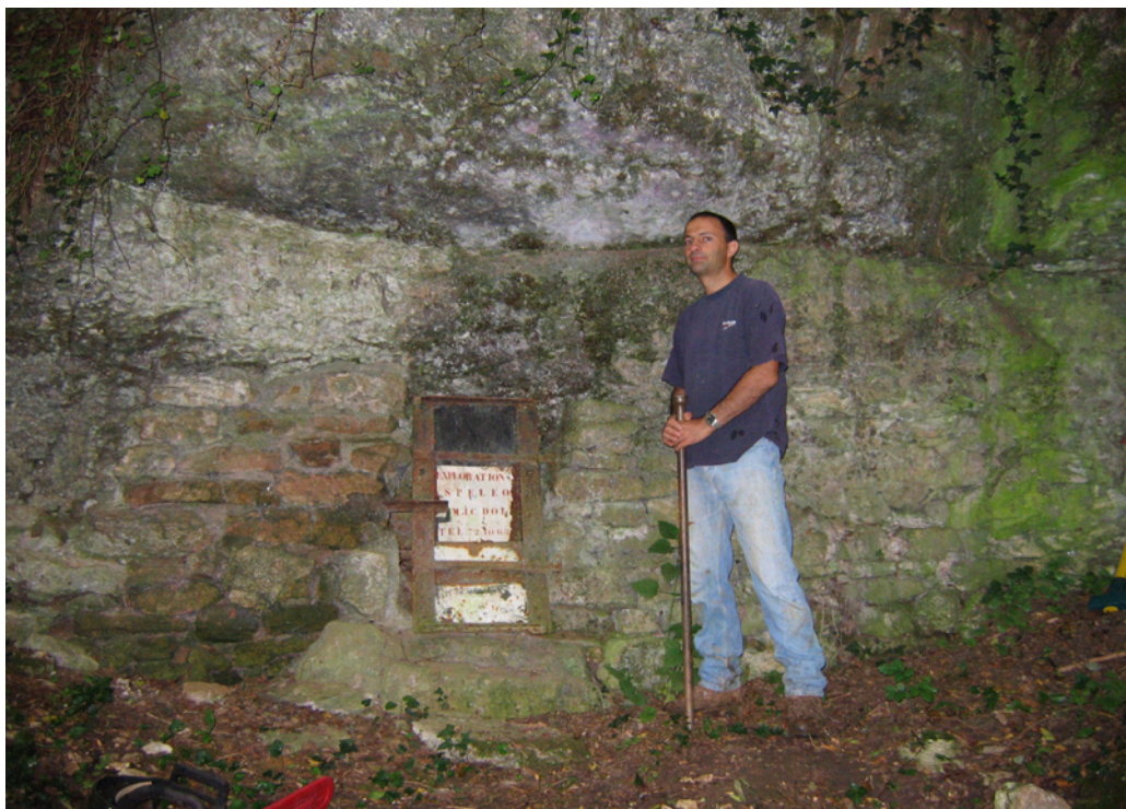
Figure 286 : détail du mur ; postérieurement à la construction, une porte a été aménagée par le club spéléologique de Dole (club aujourd'hui disparu), cliché S. David
