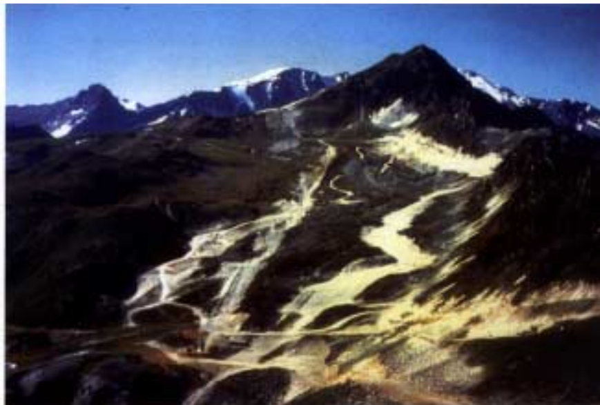
▲ Photo 2. – Piste terrassée avant végétalisation
