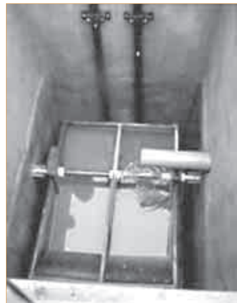
▼ Photo 2 – Auget basculeur installé après la sortie de la FTE dans une ferme de la Loire.
