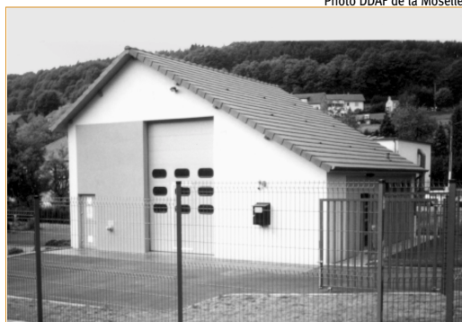
▲ Photo 2 – La station de traitement des eaux potables de Dourd'hal en mai 2000.
