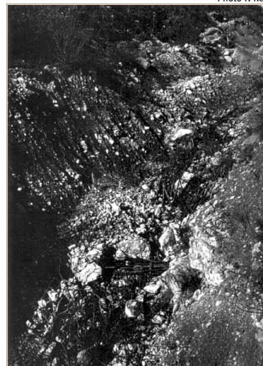
▲ Photo 3 – Clayonnages et garnissages.
